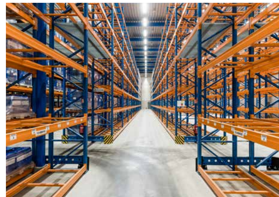
Noordland 12 en 13 bieden samen zo'n 44.000 m 2 opslagruimte en waren binnen elf maanden klaar voor gebruik.
