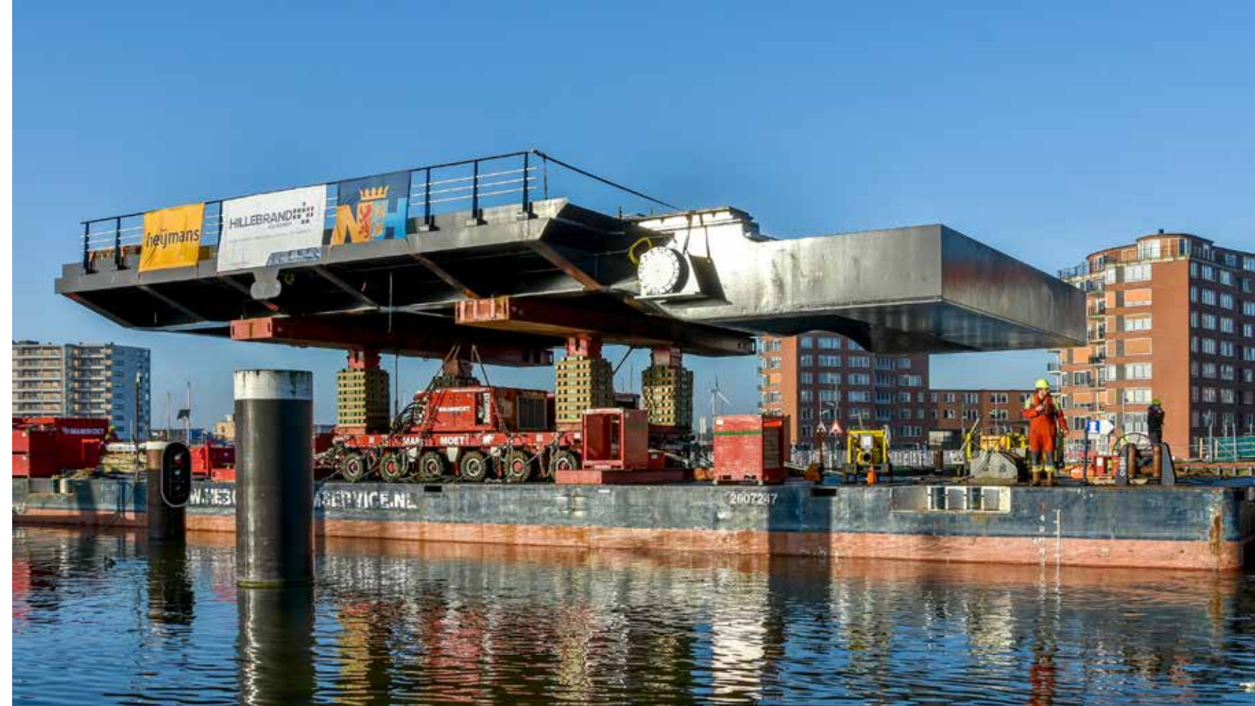
De Wilhelminabrug op hoogte gereed voor montage.
