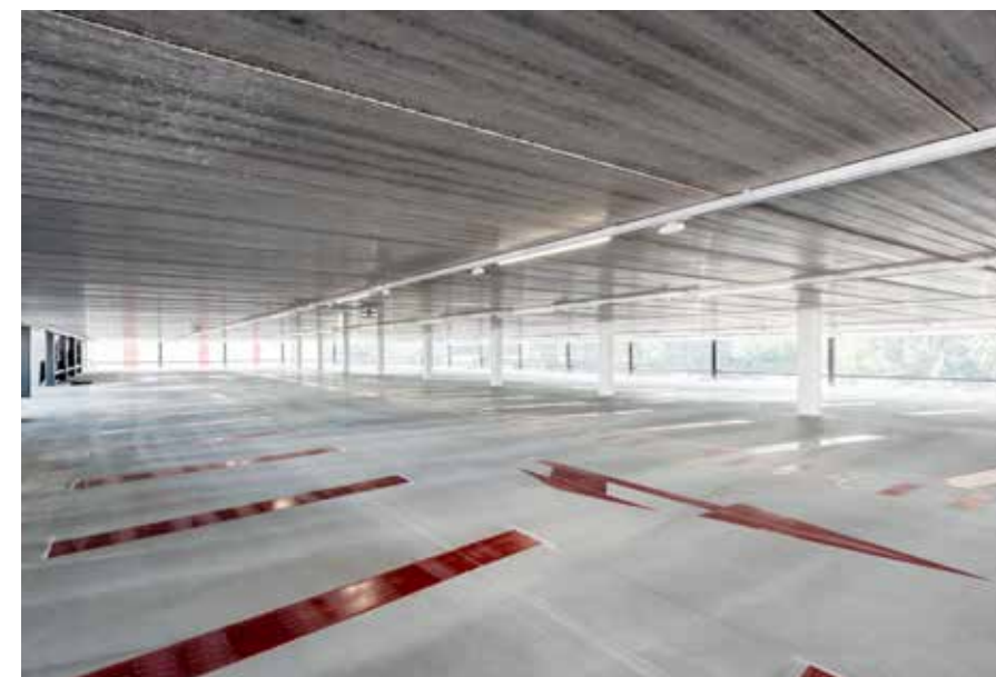
De constructie bestaat grotendeels uit staal, aangevuld met vloerplaten in voorgespannen betonwelfsels.
