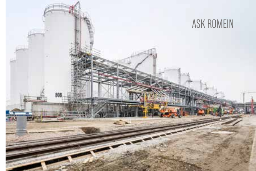
De nieuwe opslagterminal van STANDIC in de Antwerpse haven is opgetrokken uit 1.112 ton staal.
