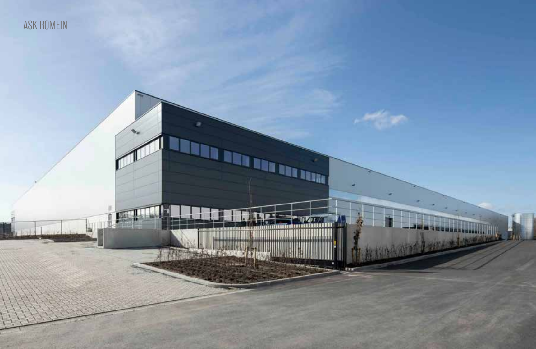
Het logistieke complex van Logistics Capital Partners in Zuid-Nijvel werd op amper tien maanden tijd gerealiseerd.
