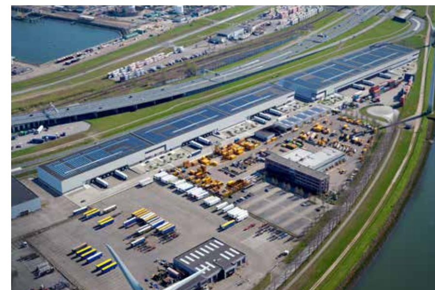
Samen met industrieel vastgoedontwikkelaar Prologis vormde ASK Romein Bouw een verlaten industrieterrein om tot een hoogwaardig nieuw distripark.
