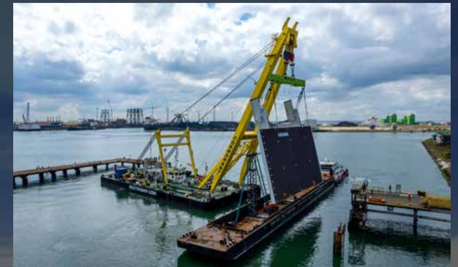
De toegang tot open water levert het voordeel op om zonder belemmering de gigantische stukken te transporteren.
