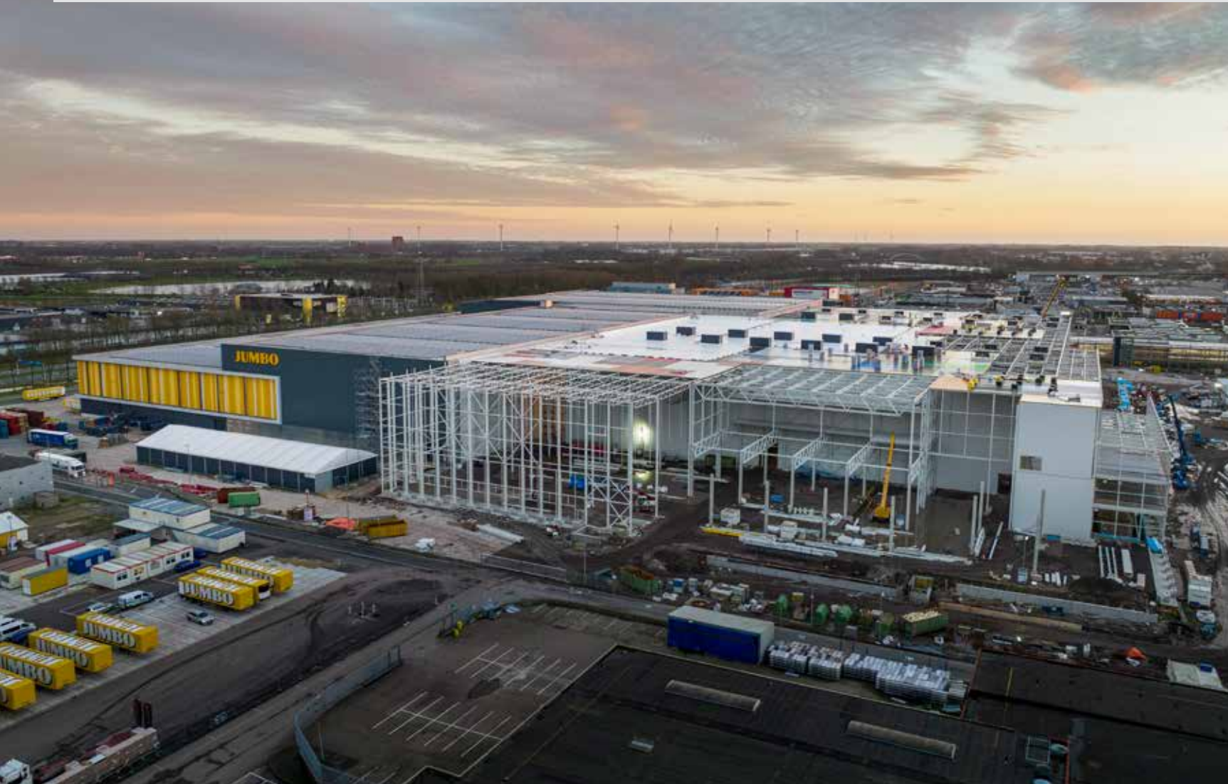
Het centraal distributiecentrum (CDC) voor Jumbo Supermarkten wordt niet alleen een visuele eyecatcher op bedrijventerrein De Liesbosch in Nieuwegein, maar ook een toonbeeld van duurzame ontwikkeling.
